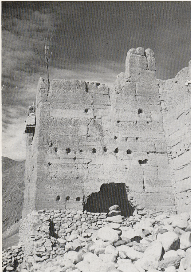
Abb. 5. Saspol, Südwestl. Eckturm der Bergfestung. Foto: E. Pfeifer
