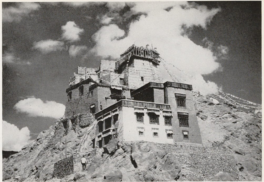
Abb. 6. Tsemo, Klosterburg mit mächtigem Wohnturm. Bemerkenswert der vorkragende hölzerne Wehrgang. Foto: E. Pfeifer
