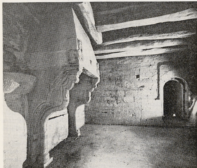
Burg Neipperg, offener Kamin des 13. Jahrhunderts im Wohnturm
