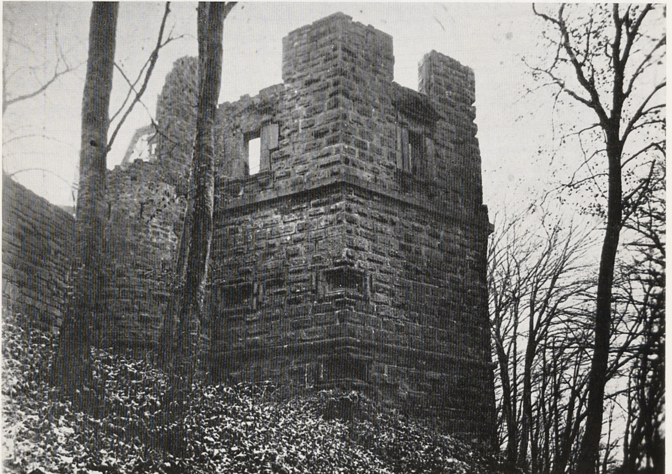
Abb. 3. Burg Hohbarr. Batterieturm und Wendeltreppenturm — Zustand 1931 (Foto: G. Czarnowsky)
