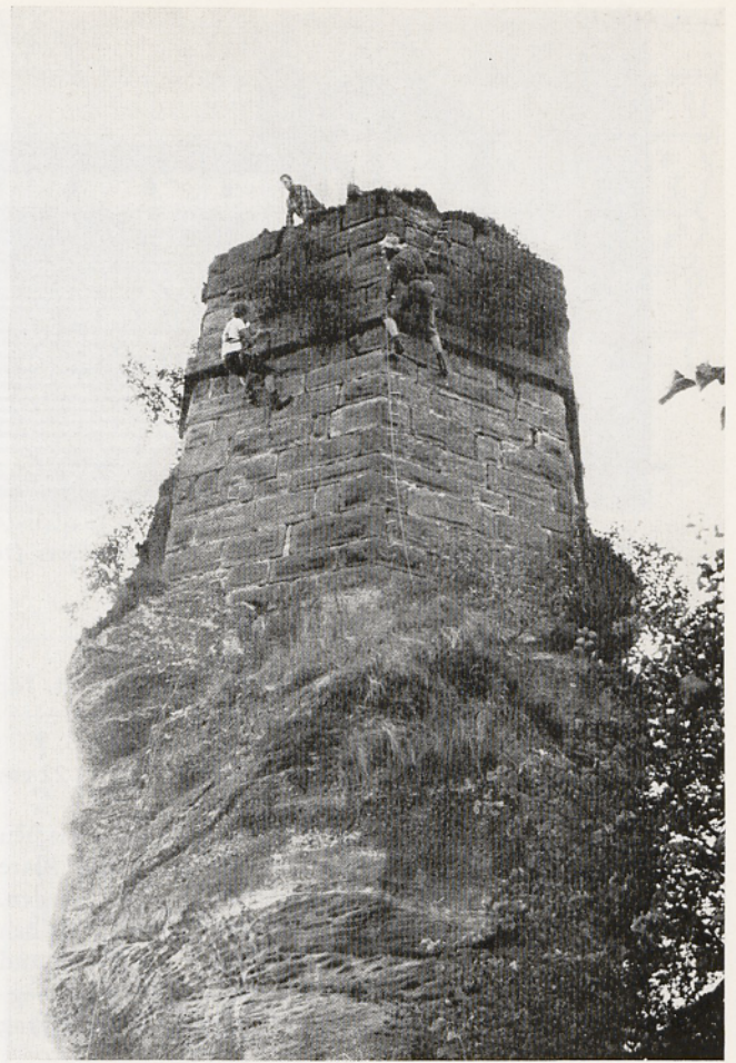
Abb. 4. Burg Hohbarr. Maßaufnahme auf dem Schnabel mit Hilfe einer Bergsteigergruppe (Foto: René Kill)
