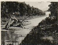
Bürstenkopf-Saugbagger mit Schlammwurf oder mit schwimmenden Leitungen.
