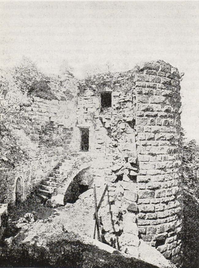
Abb. 8. Rest der nördlichen Ringmauer der Westanlage im Nordturm des „Großen Bollwerkes“ von Osten (nach Ebbardt 1908 — Anm. 6 — Abb. 26)
