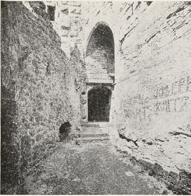
Abb. 2. Osttor der Kernburg mit Tragbogen darüber (nach Ebhardt 1908 — Anm. 6 — Abb. 28)
