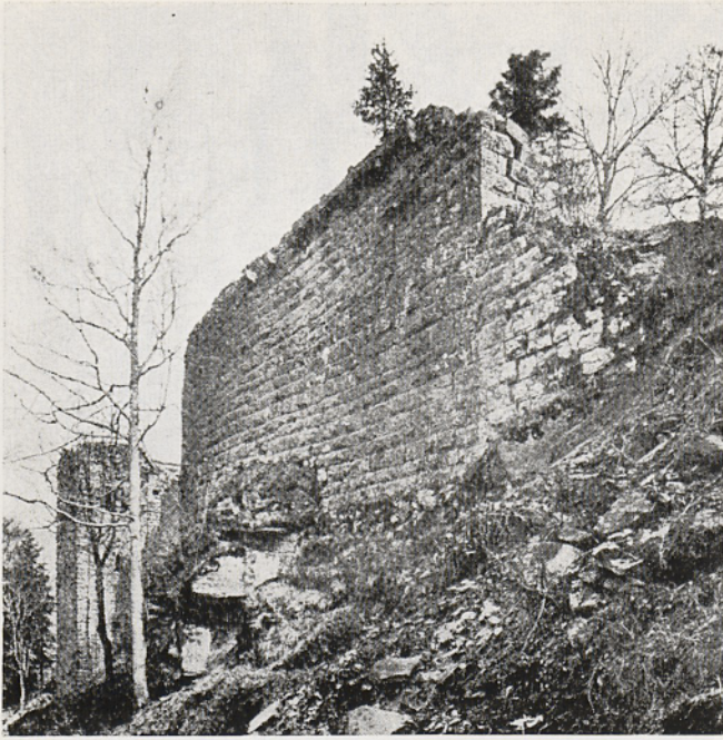
Abb. 7. Außenwand eines Wohnbaues (Mitte 12. Jh.) in der nördlichen Ringmauer der Westanlage, von Nordwesten (nach Ebbardt 1908 — Anm. 6 — Abb. 58)
