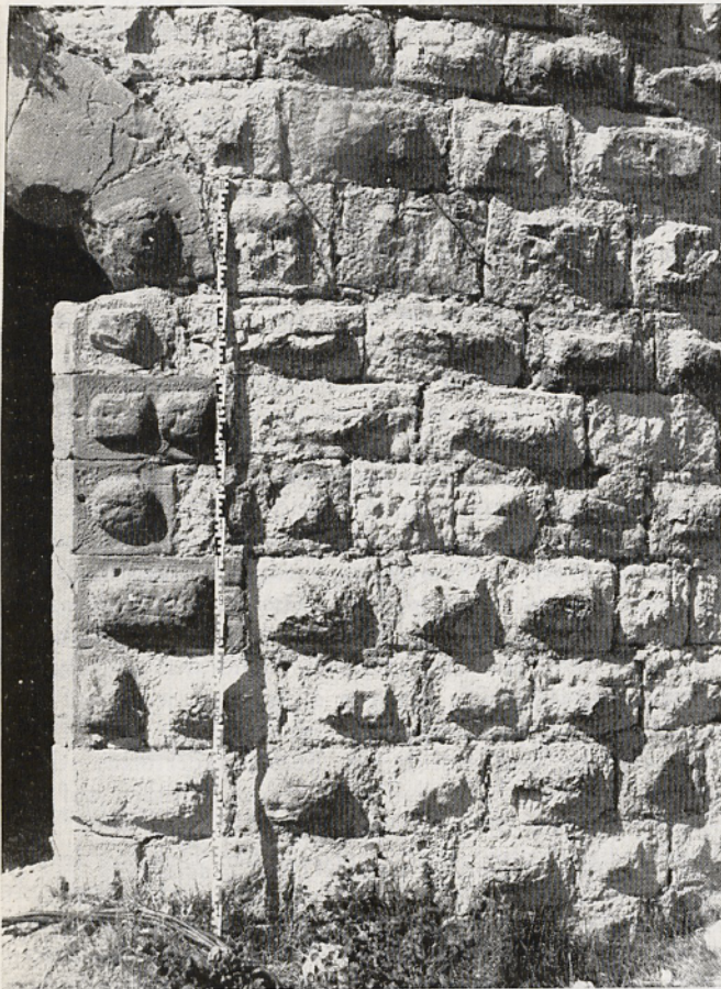
Abb. 4. Puivert, Ausschnitt Buckelquaderturm. Foto: Meckseper
