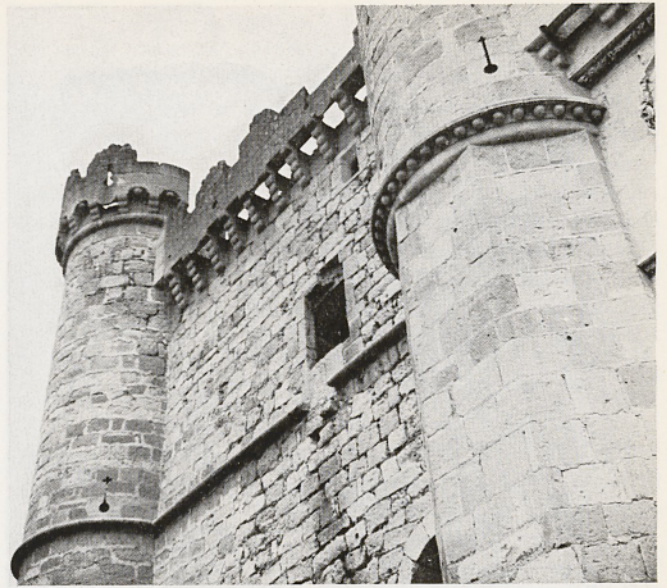
Abb. 4. Turégano, Maschikulinrichtung an der Kirche. Foto: Kafka
