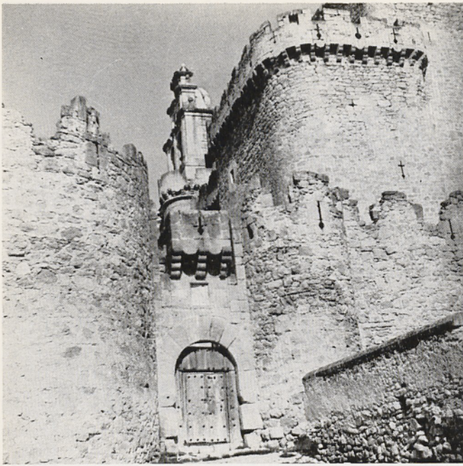
Abb. 7. Turégano, Östliche Toranlage. Foto: Kafka
