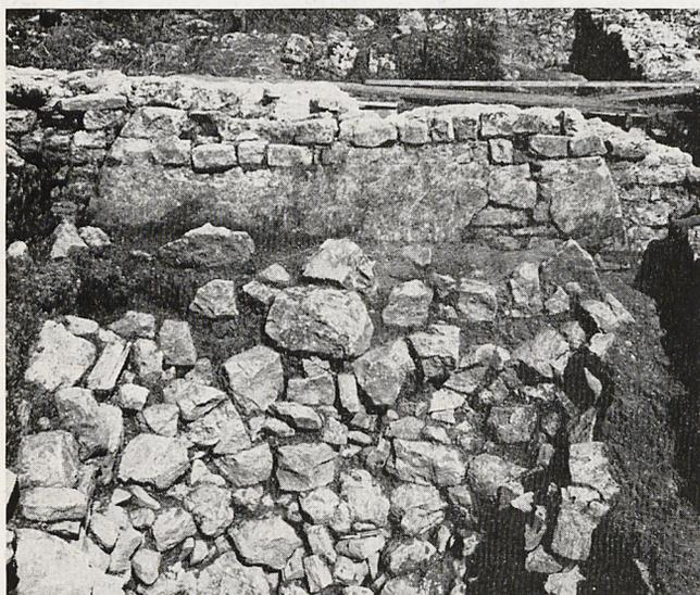
Abb. 6. Froburg SO, mittlere Zisterne. Verputzter Innenmantel und Ansatz des Tonnengewölbes für die Tankzisterne, davor nachträglich eingefüllter Filtrierkörper
