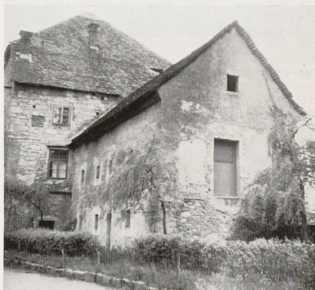
Abb. 7. Zirknitz, Kirchhofgaden, anschließend Wohnturm. Foto: Kafka
