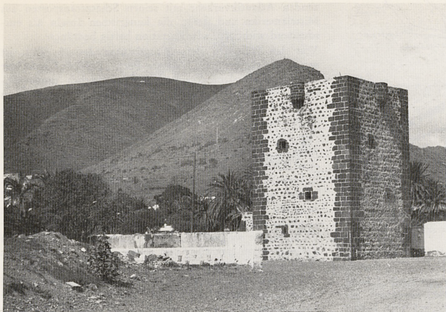
Abb. 1 und 2. Der Grafenturm am Hafen von San Sebastián, La Gomera. Er ist in drei Geschossen 16 m hoch bei einem Grundriß von 11 x 11 m. Der Zugang liegt ca. 5 m über dem Gelände und ist jetzt über eine Holztreppe innen und über Reste eines (späteren?) Vorbaus zu erreichen. Der Erdgeschoßraum war ursprünglich sicherlich nur vom Eingangsgeschoß aus zugänglich. Pferde werden im Vorbau gestanden haben, in dem ich jetzt eine alte Columbusfabne und die Kopie eines Portraits der Königin Isabel I. fotografierte. Rechts: Detail eines der vier Kampferker an der oberen Plattform des Turms. Sie sind in dieser Form nur hier erhalten
