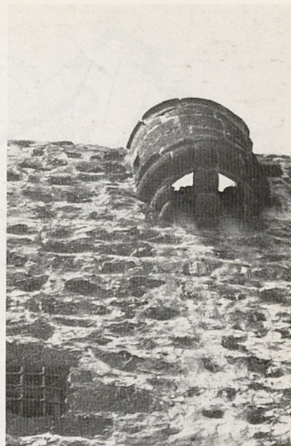
Abb. 1 und 2. Der Grafenturm am Hafen von San Sebastián, La Gomera. Er ist in drei Geschossen 16 m hoch bei einem Grundriß von 11 x 11 m. Der Zugang liegt ca. 5 m über dem Gelände und ist jetzt über eine Holztreppe innen und über Reste eines (späteren?) Vorbaus zu erreichen. Der Erdgeschoßraum war ursprünglich sicherlich nur vom Eingangsgeschoß aus zugänglich. Pferde werden im Vorbau gestanden haben, in dem ich jetzt eine alte Columbusfabne und die Kopie eines Portraits der Königin Isabel I. fotografierte. Rechts: Detail eines der vier Kampferker an der oberen Plattform des Turms. Sie sind in dieser Form nur hier erhalten
