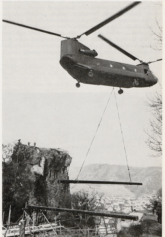
Abb. 2. Burgruine Rheingrafenstein, Einfügen der neuen Brücke
