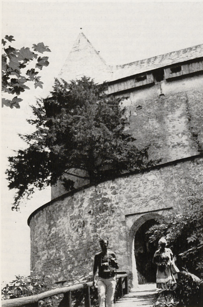
Abb. 6. Burg Staufeneck, Burgtor und Wehrgang (Foto A. v. L.)
