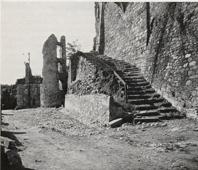
Abb. 3. Hochburg, Burg, Ostzwinger von Norden gesehen mit „Eselsritt“, Schneckenkasten und Treppenturm nach Freilegung und Konservierung
