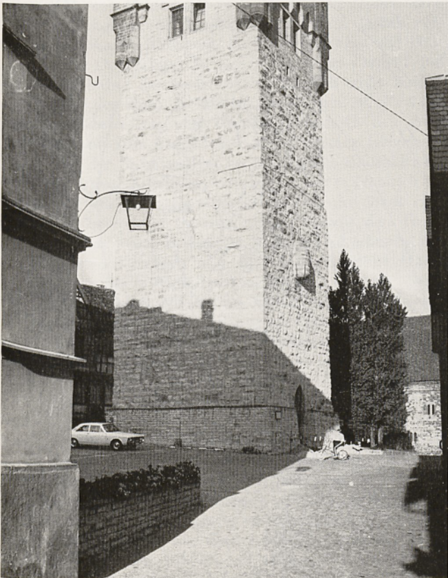
Abb. 13. Wimpfen. Blauer Turm, neugesichert nach Abnahme der Eisenanker (Photo: Arens 1977)
