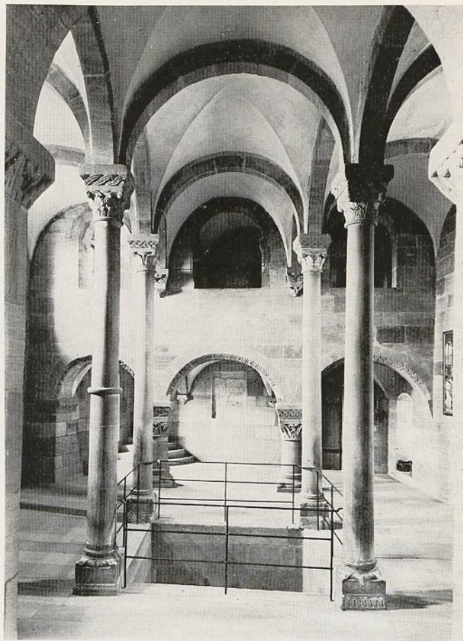
Abb. 11. Nürnberg. Burgkapelle, Obergeschoß nach Westen mit der Königsempore (Photo: Arens)
