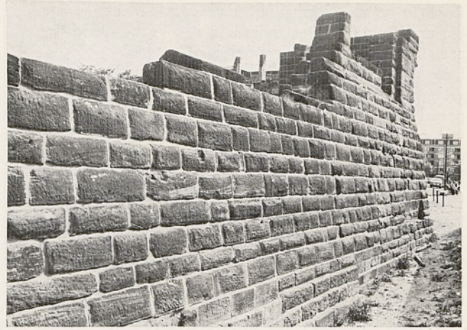
Abb. 2. Kaiserlautern. Sockelmauer des Palas von Süden her (vom linken Bauteil der Abb. 1. — Photo: Arens)
