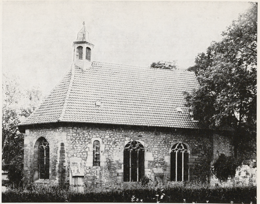
Abb. 12. Steuerwald, Kapelle, 1507 an den westlichen Mauerring angebaut. Foto: Wangerin
