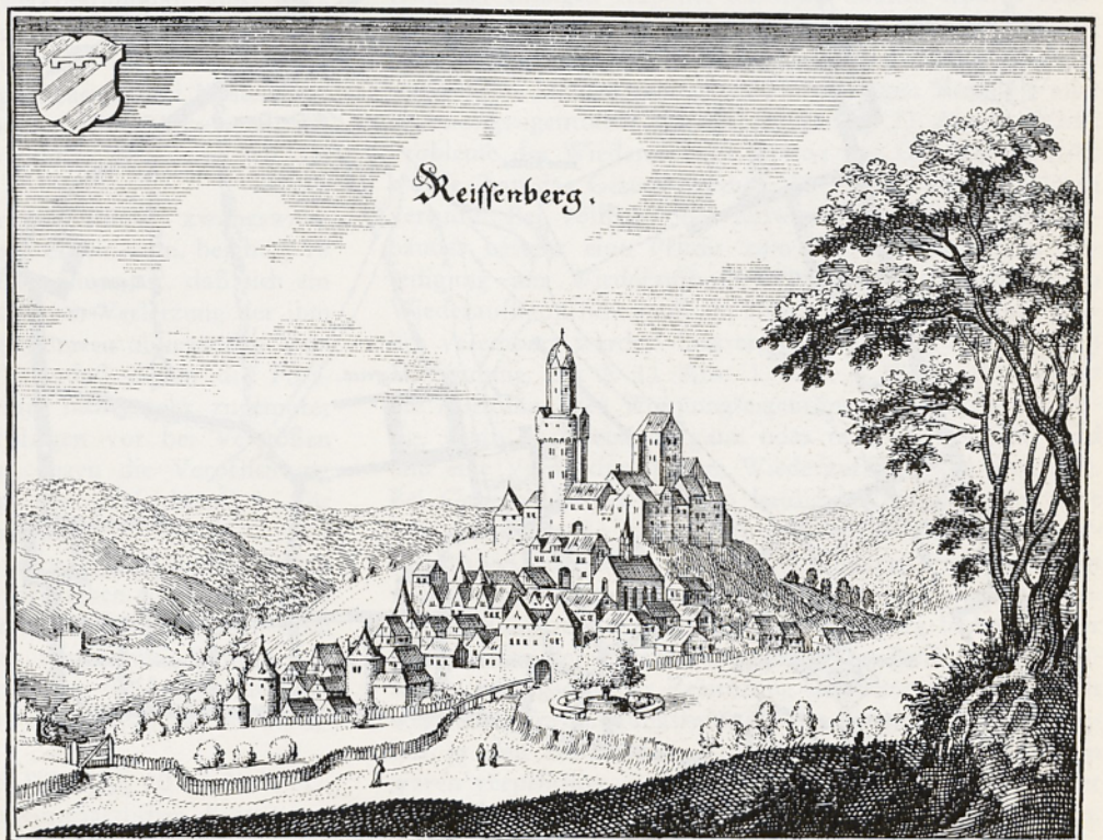
Abb. 4. Burg Reiffenberg, Burgansicht nach Merian, Ganerbenburg seit Eintritt in die geschichtliche Überlieferung
