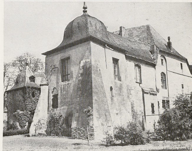
Abb. 3. Wasserburg Kray, Südturm mit Burgkapelle. Foto: Dr. Otto v. Fisenme
