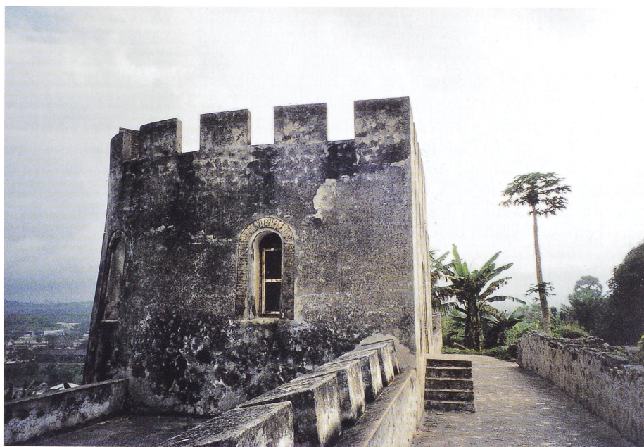
Abb. 8. Festung Großfriedrichsburg, Turm (Foto: Verf.).
