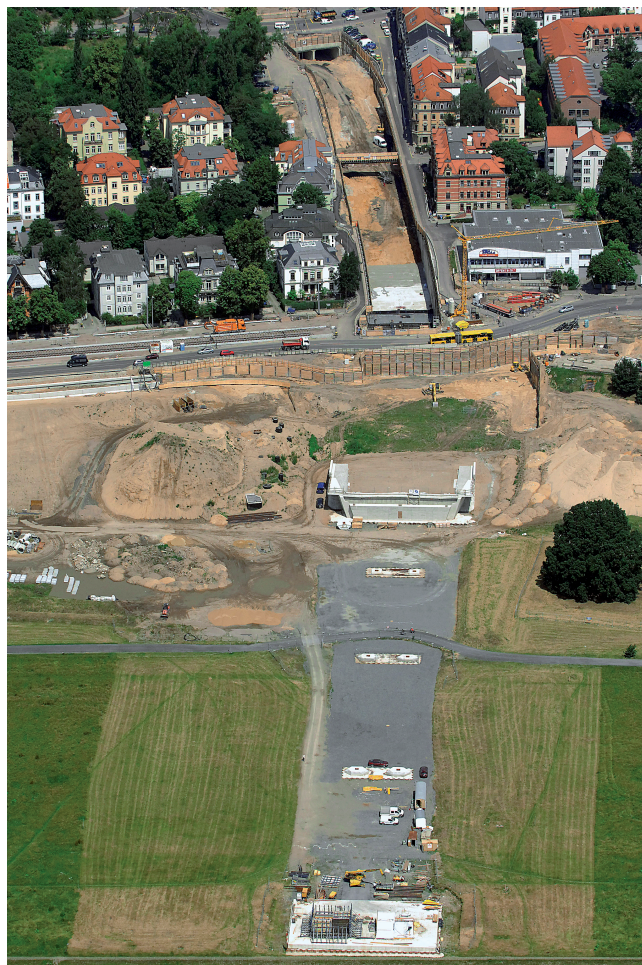
Abb. 1. Blick auf die im Bau befindliche Waldschlösschenbrücke in Dresden, aufgenommen am 17.06.2009 (dpa).
