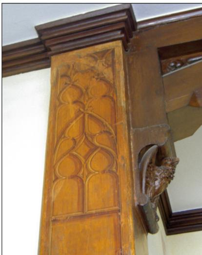
Abb. 13. „Holz“Bemalung. Detail wie Abb. 10, jedoch nach der Retusche. Stuckgesimse des Saales wurden nach Befund dunkel gefasst (Foto: S. Co-dreanu, BlfD Regensburg).
