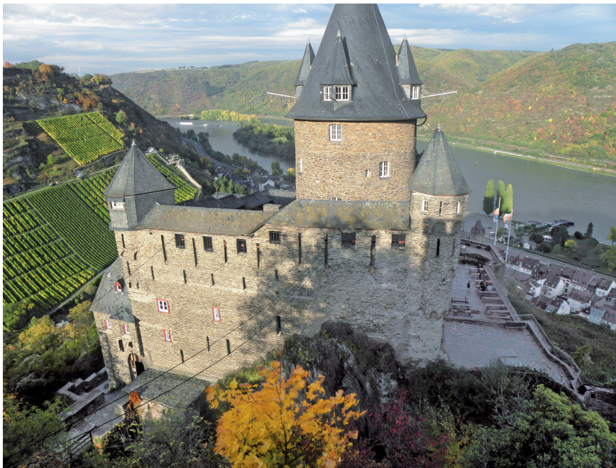
Abb. 2. Blick auf Schildmauer und Bergfried, beide erbaut nach 1922. Auf dem in der Bildmitte ersichtlichen Felsen befindet sich das mittelalterliche Mauerwerk des allein von der originalen Schildmauer erhaltenen Mauerzahns, der durch die optisch leicht abweichenden Mörtelfugen zu identifizieren ist (Foto: Verf.).
