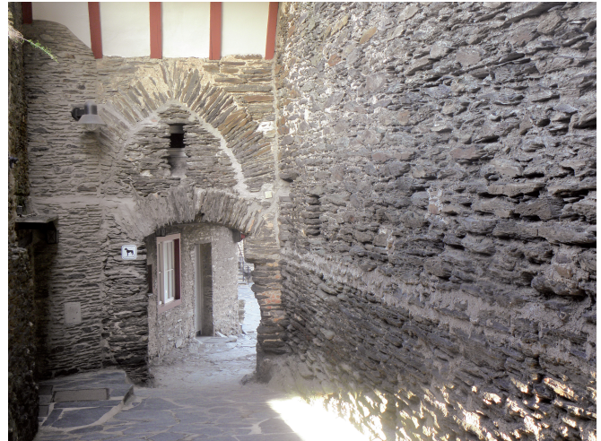
Abb. 7. Blick auf das um 1934 restaurierte Tor der Burgruine Reichenstein bei Neckargemünd. Die links im Bild erkennbare Buckelquaderecke ist ebenfalls als Werk der Restaurierung zu vermuten, da die Burgruine ansonsten keine Buckelquader aufweist. Wie das Stahlecker Tor ist auch dieses unzweckmäßig schmal (Foto: Verf.).
