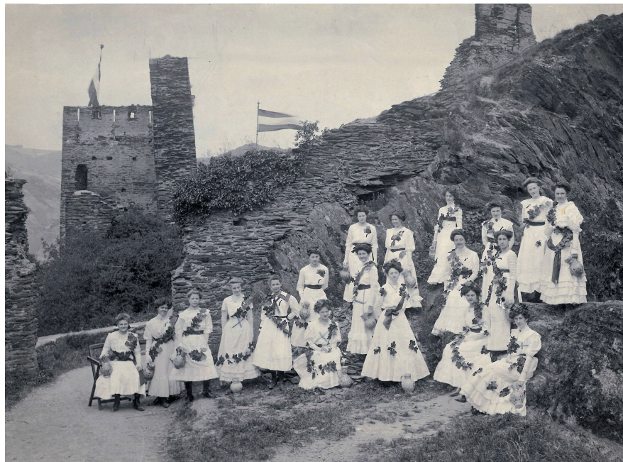
Abb. 9. Burgruine Stahleck als Staffage für Ehrendamen eines Fests um 1900. Die Damen hatten sich im Gelände der Vorburg für den Fotografen versammelt; im Hintergrund links ist die nördliche Ringmauerflanke der Kernburg zu sehen (Foto: Europäisches Burgeninstitut).
