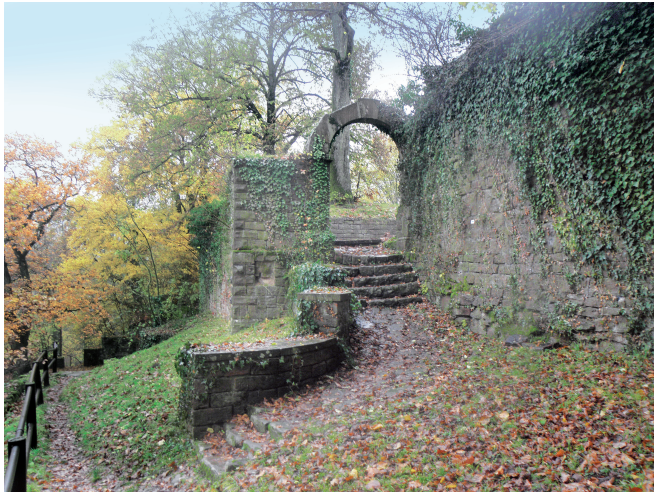
Abb. 7. Blick auf das um 1934 restaurierte Tor der Burgruine Reichenstein bei Neckargemünd. Die links im Bild erkennbare Buckelquaderecke ist ebenfalls als Werk der Restaurierung zu vermuten, da die Burgruine ansonsten keine Buckelquader aufweist. Wie das Stahlecker Tor ist auch dieses unzweckmäßig schmal (Foto: Verf.).
