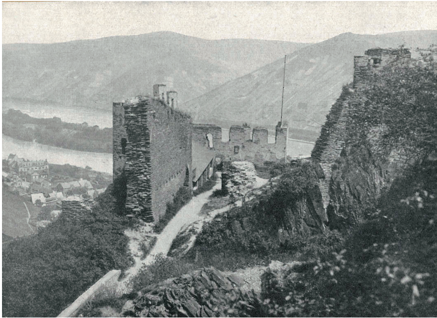
Abb. 4. Historisches Foto der Burgruine. Im Vordergrund die Reste der Schildmauer mit dem Mauerzahn auf dem Felsen, links die nördliche Ringmuerflanke mit original erhaltenen Zinnen. An der Talseite ist die später in den Neubau einbezogene Hofwand des Hauptgebäudes mit Hocheingang (links) und hochrechteckigen Fensterhöhlen erkennbar. In die Fensterhöhlen setzte Ernst Stahl nach 1934 neu angefertigte Kreuzstockfenster ein (Foto: Europäisches Burgeninstitut).
