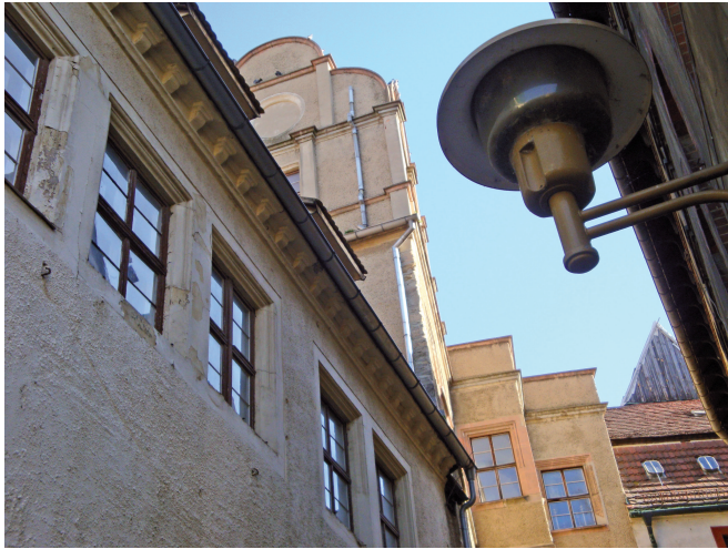
Abb. 4. Kühler Brunnen, Teilrestaurierter Zustand (Foto: Jana Schwarze, 2012).
