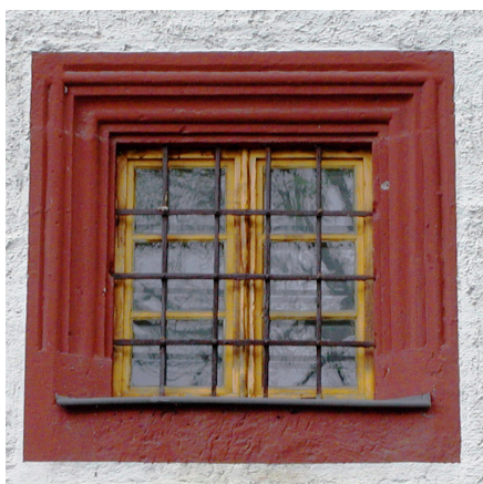
Abb. 11. Außenansicht eines Fensters mit reich profiliertem Gewände (heute Bereich Damen-WC im Erdgeschoss).
