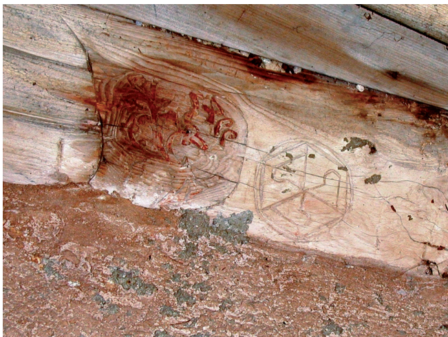
Abb. 5. Das Relief an einem Randbalken im Wohnturm (zweites Obergeschoss), mit dem sich der Zimmermeister „verewigt“ hat: neben dem Meisterzeichen ein rot markiertes Relief mit der spiegelbildlichen Jahreszahl 1499.
