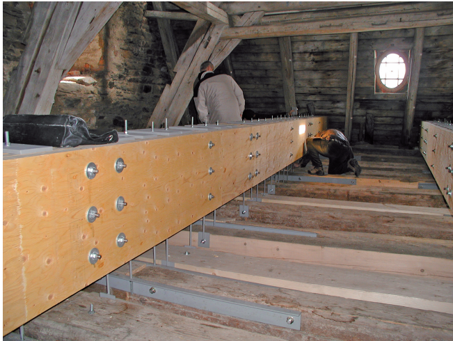
Abb. 22. Die neuen Überzüge und die Aufhängung des Gebälks vor Verlegung des Bretterbelags.
