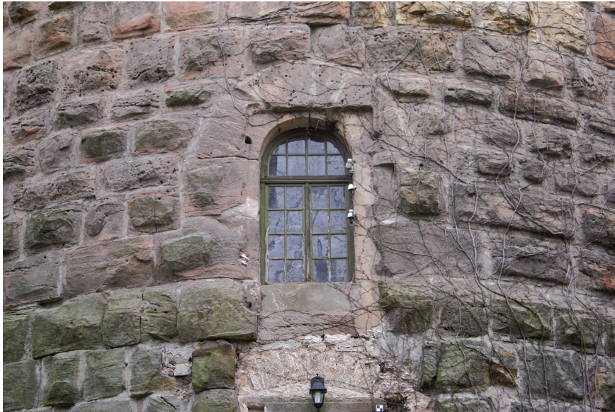
Abb. 6. Schloss Tonndorf, Bergfried, Hocheinstieg von Westen.
