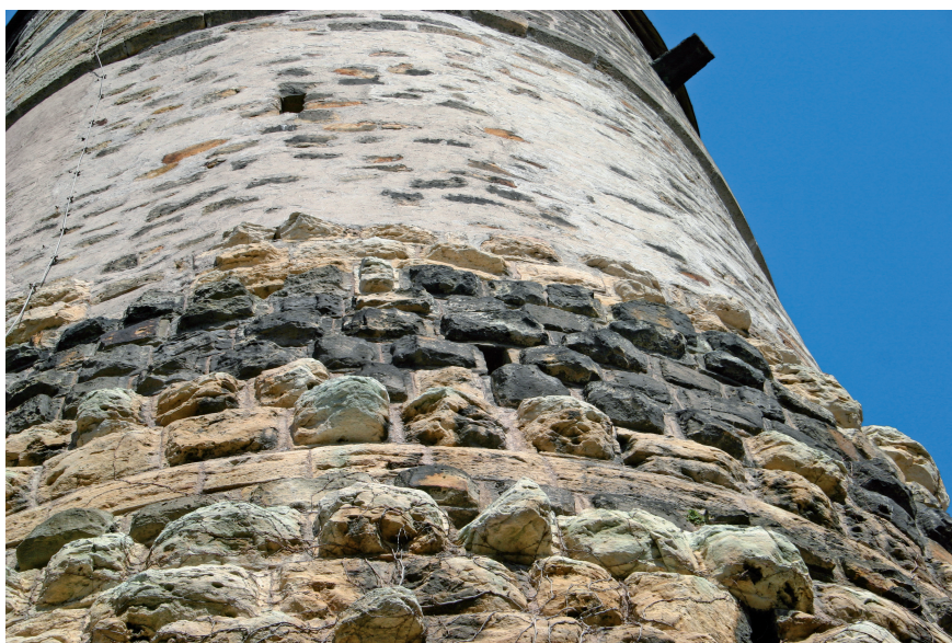
Abb. 10. Schloss Tonndorf, Bergfried, Glattquaderband am oberen Ende des romanischen Turmschafts.
