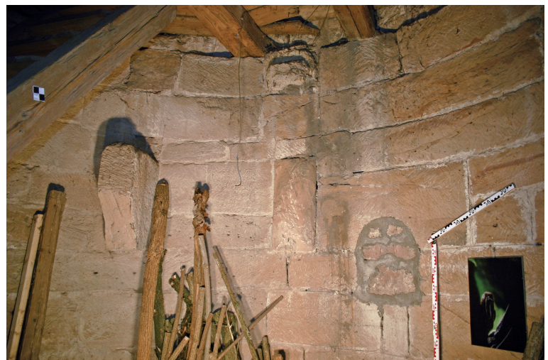
Abb. 8. (unten) Schloss Tonndorf, Bergfried, Fragmente des Kamins und zugesetztes Schlitzfenster im Einstiegsgeschoss von Nordwesten.
