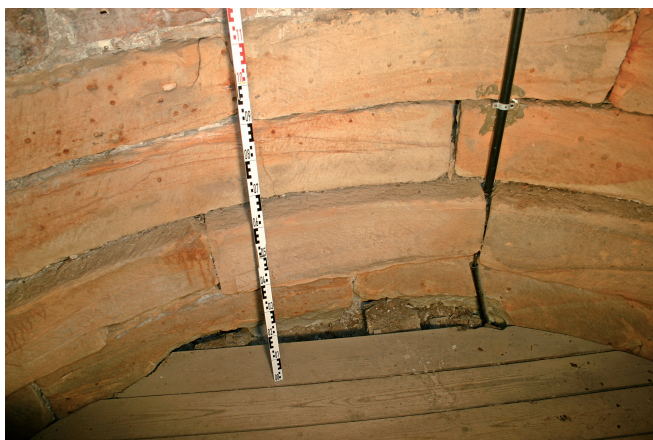
Abb. 11. Schloss Tonndorf, Bergfried, vorgekragte Steinreihe als Auflagerbereich der Balkendecke zwischen drittem und viertem Obergeschoss von Süden.
