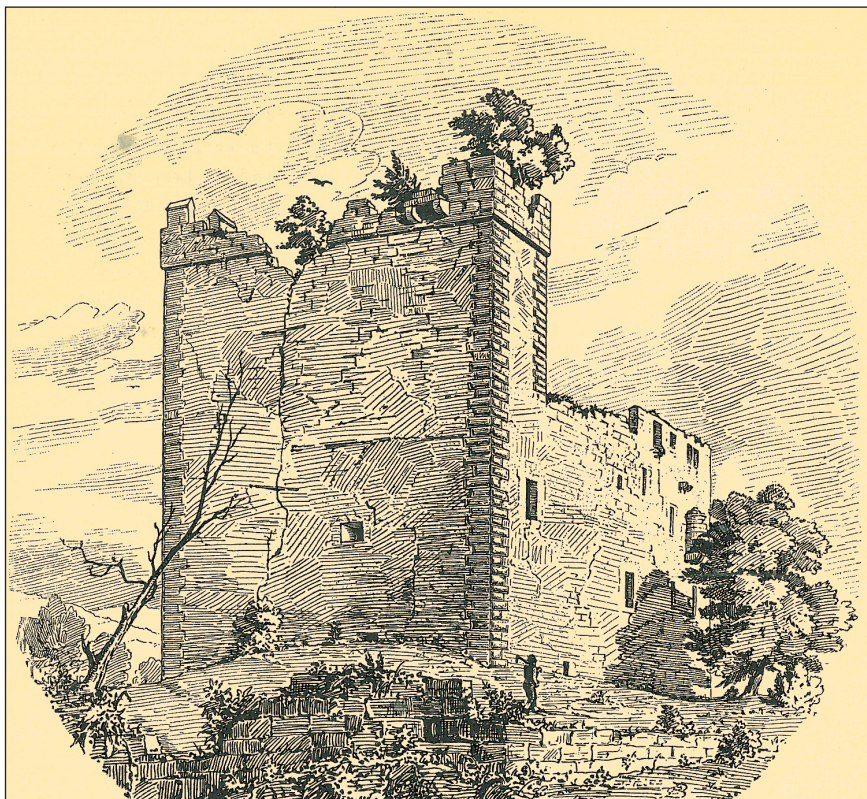
Abb. 1. Die Schildmauer der Burgruine Freienstein im Zustand vor 1891, Zeichnung von Carl Bronner. Der gut erkennbare breite Riss führte im Frühjahr 1988 zum weitgehenden Einsturz der damals bereits nicht mehr in voller Höhe erhaltenen Schildmauer (aus: Kunstdenkmäler im Großherzogthum Hessen, Provinz Starkenburg, Kreis Erbach , hrsg. von Georg Schäfer, Darmstadt 1891, S. 102).
