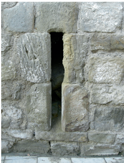
Abb. 9. Lichtschlitz im Basisgeschoss.
