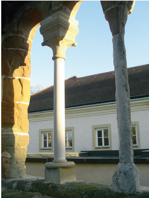
Abb. 8. Triforie mit erneuerten Säulen.
