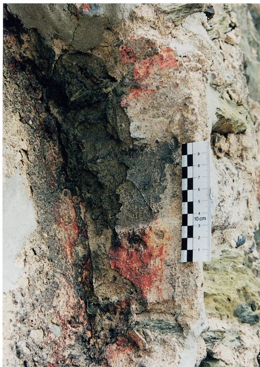
Abb. 8. (links) Putz- und Farbbefund am Bogenfries des Pulverturms (Foto: F. Lawen).
