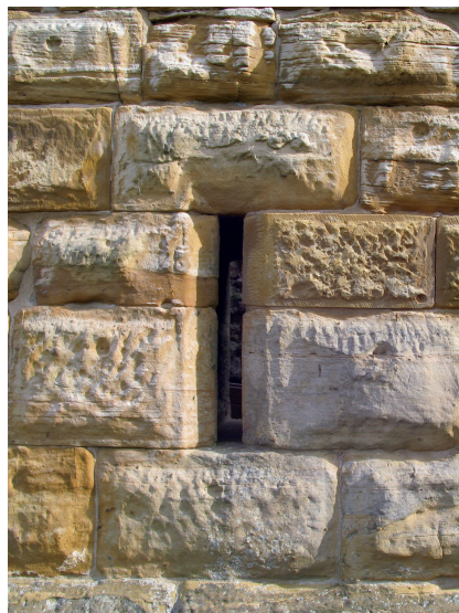
Abb. 4. Burg Rechberg, „Arkadenmauer“, Fenster III von außen. Der Schlitz hat ein Lichtmaß von 10/85 cm (Foto: Verf. 2009).
