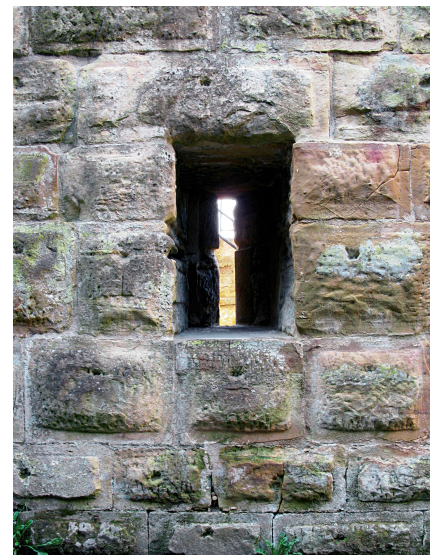
Abb. 5. Burg Rechberg, „Arkadenmauer“, Fenster IV von innen. Die Fensteröffnung ist etwa 55 cm breit und etwa 85 cm hoch (Foto: Verf. 2015).
