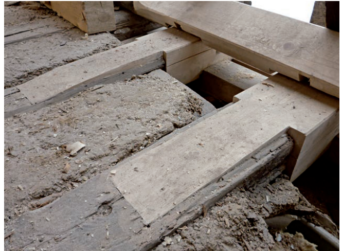
Abb. 3. Reparatur der Balkenköpfe (Foto: C. Altemüller).
