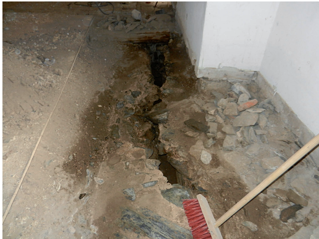
Abb. 2. Gewölbeabriss im Südflügel (Foto: S. Naujack).
