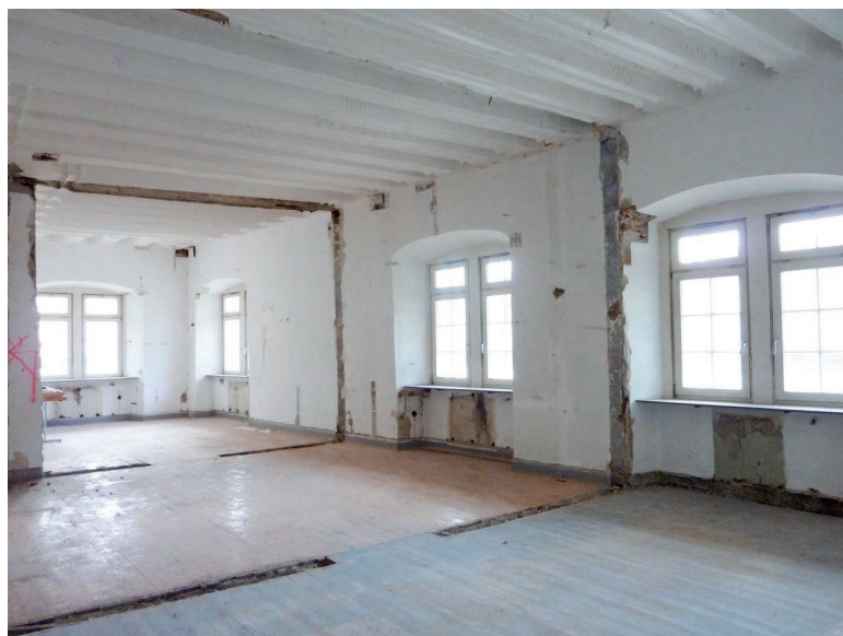
Abb. 10. (unten) Saal im ersten Obergeschoss des Rheinflügels nach Herausnahme der nachträglichen Einbauten (Foto: S. Naujack).
