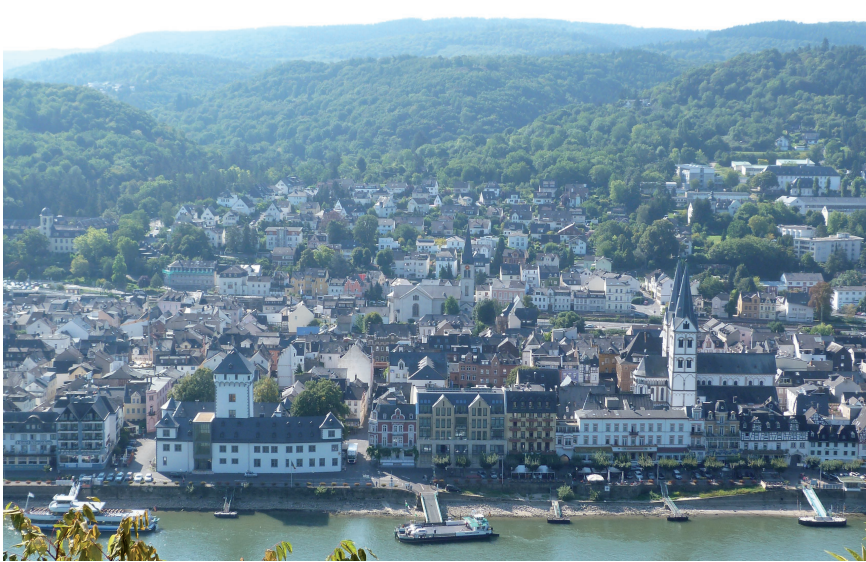
Abb. 1. Kurfürstliche Burg in Boppard nach der Instandsetzung und kurz vor der Wiedereröffnung (Foto: M. Holdorf, 11.9.2015).
