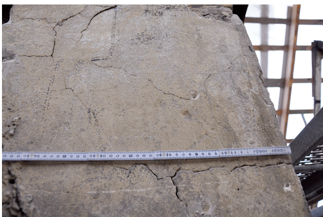
Abb. 4. Außenputzbefund am Nordostpavillon mit Eckquaderung (Foto: K. Keller).
