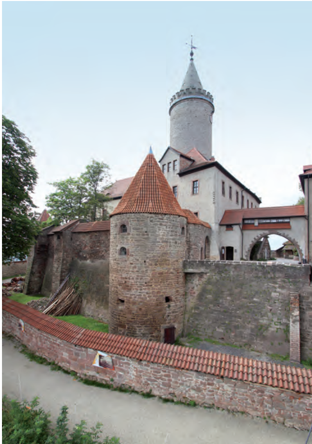
Abb. 2. Leuchtenburg, Kernburg mit Bergfried und Amtshaus von Norden, im Vordergrund Zwingerbefestigung mit Kleiderturm und gefüttertem Graben (Foto: Benjamin Rudolph, 2015).
