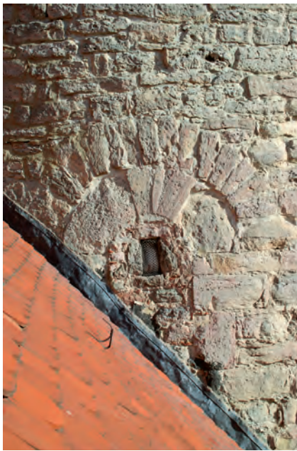
Abb. 5. Leuchtenburg, Bergfried, Hocheinstieg von Südwesten (Foto: Benjamin Rudolph, 2010).
