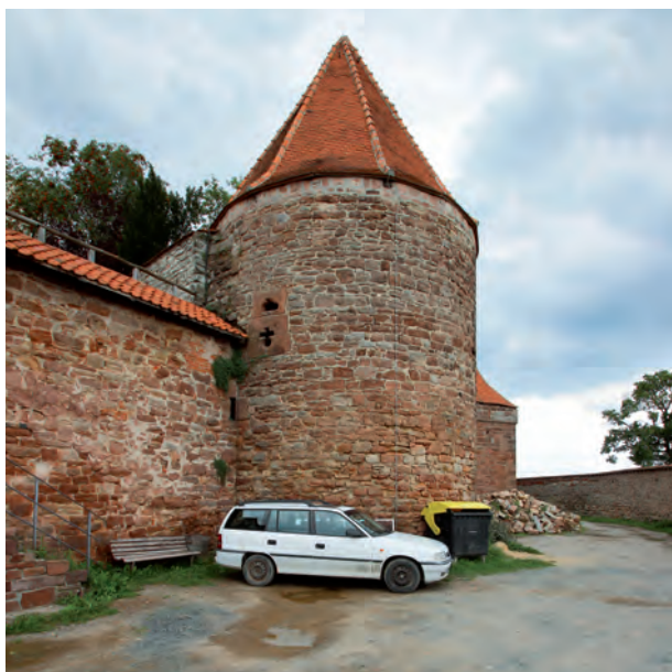
Abb. 21 Leuchtenburg, Marterturm von Westen (Foto: Benjamin Rudolph, 2014).
