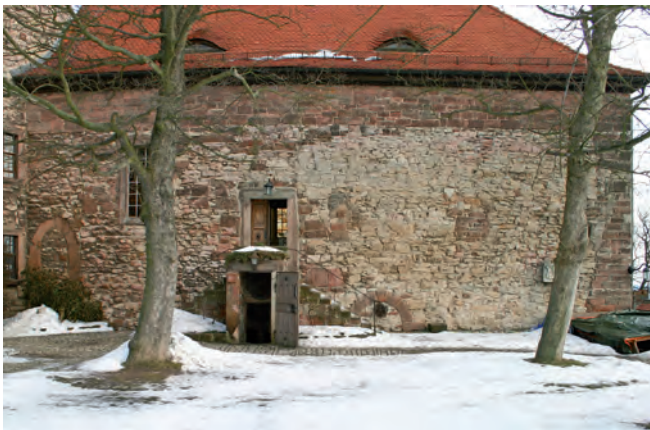
Abb. 8. Leuchtenburg, Kirche, Südmauer von Süden (Foto: Benjamin Rudolph, 2010).
