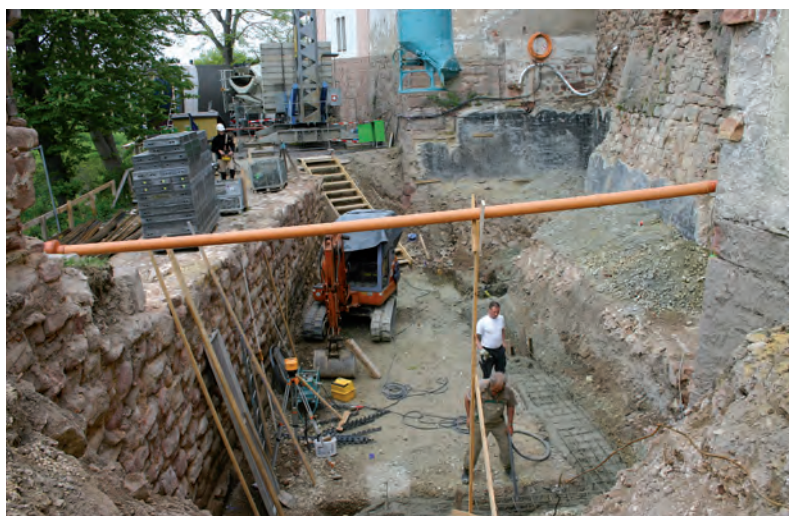
Abb. 10. (oben) Leuchtenburg. Das ergrabene Ringmauerfundament (Befund 55) wurde im Boden erhalten. Das setzte eine Umplanung des Neubaus voraus.
