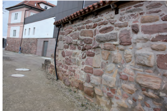
Abb. 15. Leuchtenburg. Der Bauzustand der jetzigen Zwingermauer.
