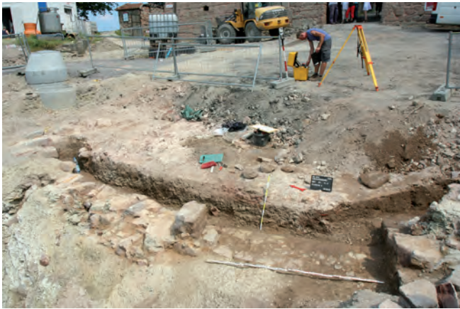
Abb. 14. Leuchtenburg. Die gesamte Toranlage.
