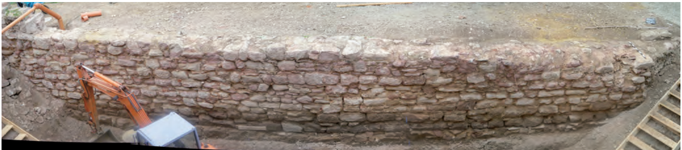
Abb. 8. Leuchtenburg. Die äußere Ringmauer im Südsüdwesten bei der neuen Technikzentrale (Befund 55) konnte auf einer Länge von 19,50 m und einer Höhe von 3,10 m aufgenommen werden.
