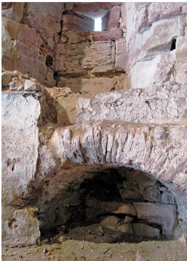
Abb. 23. In der Turmscheune P oben die Schießscharte im Erdgeschoss, darunter in der weitgehend verfüllten Nische erkennbar die Werksteineinfassung der Schießscharte im verschwundenen Tiefgeschoss. Man beachte auch die Brandspuren an den Werksteinen (Foto: Verf., 2016).
