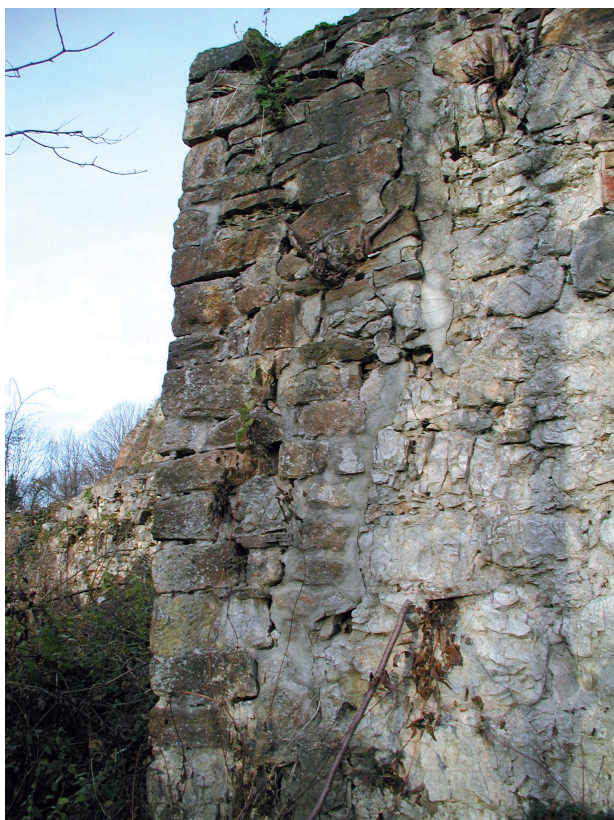
Abb. 13. (unten links) An der schwer zugänglichen Außenseite wird deutlich, dass die Mauerqualität des Bestands nicht dem entspricht, was man für solche aus dem 15. Jahrhundert erwarten darf (Foto: Verf., 2008).
