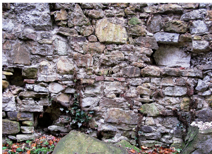
Abb. 10. Im Kontrast zum Mauerwerk von Abb. 9 hier Reparaturmauerwerk aus der Zeit nach 1648 (Foto: Verf., 2012).
