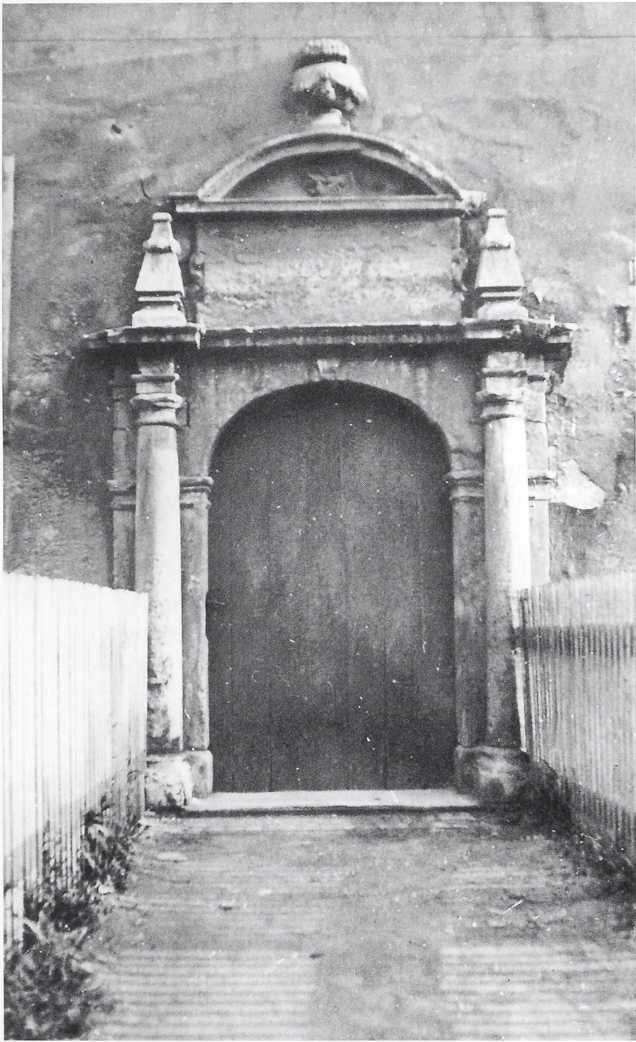
Abb. 5. Geiselröhlitz, Eingangsportal des Rittergutes (Foto von 1948, Archiv des Verf.).
