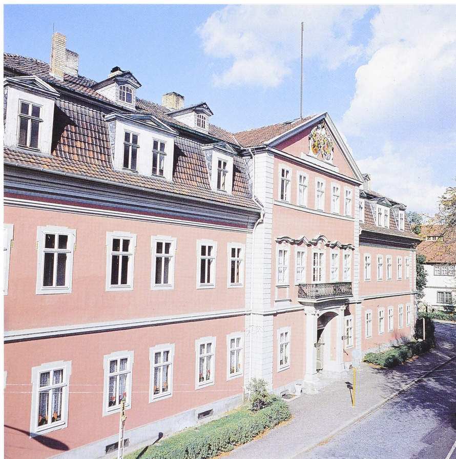
Abb. 2. Fürstliches Palais Arnstadt, Ostfassade von Süden. Zustand um 1985 (Foto: Schloßmuseum Arnstadt).
