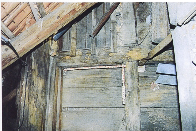
Abb. 9. und 10. Befund zur hofseitigen Eindeckung des Corps de logis vor der Planänderung zur Aufstockung der Seitenflügel: Reste der ursprünglichen Dachdeckung (Dachlatten; auf Traufbalken vermörtelte handgestrichene Hohlpfannen) an der Anschlußstelle des Nordflügels (Fotos: J. Orben, Erfurt).
