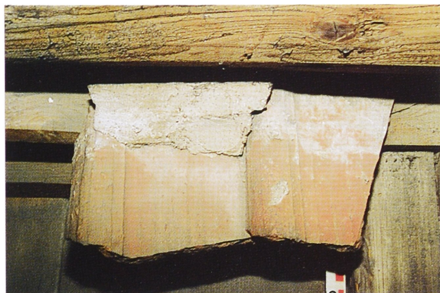
Abb. 9. und 10. Befund zur hofseitigen Eindeckung des Corps de logis vor der Planänderung zur Aufstockung der Seitenflügel: Reste der ursprünglichen Dachdeckung (Dachlatten; auf Traufbalken vermörtelte handgestrichene Hohlpfannen) an der Anschlußstelle des Nordflügels (Fotos: J. Orben, Erfurt).
