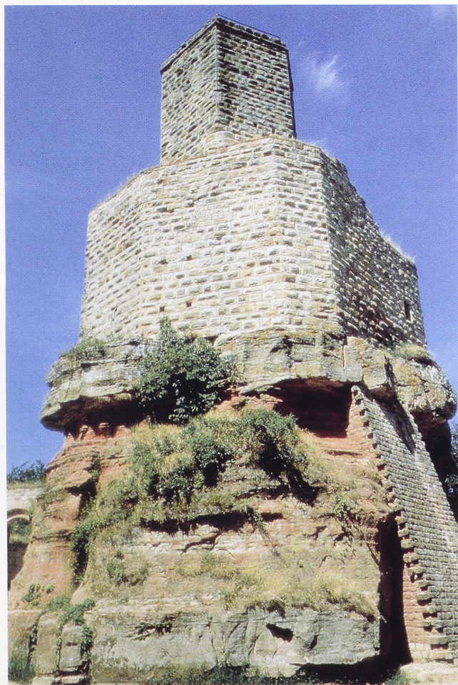
Abb. 24. Burgruine Gräfenstein, Pfalz. Stützmauer am Kernburgfelsen, 1912 (Foto: Verf.).
