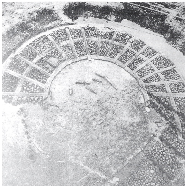
Abb. 22. Ratzeburg, Schloßinsel. Geschützrondell. Pfahlrost aus verblatteten Buchenschwellen auf eingezapften, dicht eingeschlagenen Eichenpfählen, um 1524 (nach Borrmann, Abb. 148).
