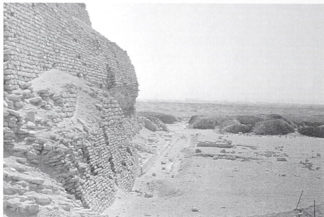
Abb. 3. Sakkara, Ägypten. Stufenpyramide des Djoser mit außen schräg gelegten Steinschichten auf dem geglätteten Felsplateau, ca. 2700 v. Chr. (Foto: Verf.).
