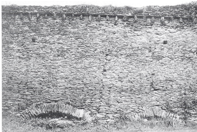
Abb. 21. Oberwesel, Rheinland-Pfalz. Stadtmauer. Abschnitt Michelfeld, Gründung am Hang mit 2 m tiefen Fundamentpfeilern und Verbindungsbögen, 1. Bauphase 1243 (Foto: Verf.).
