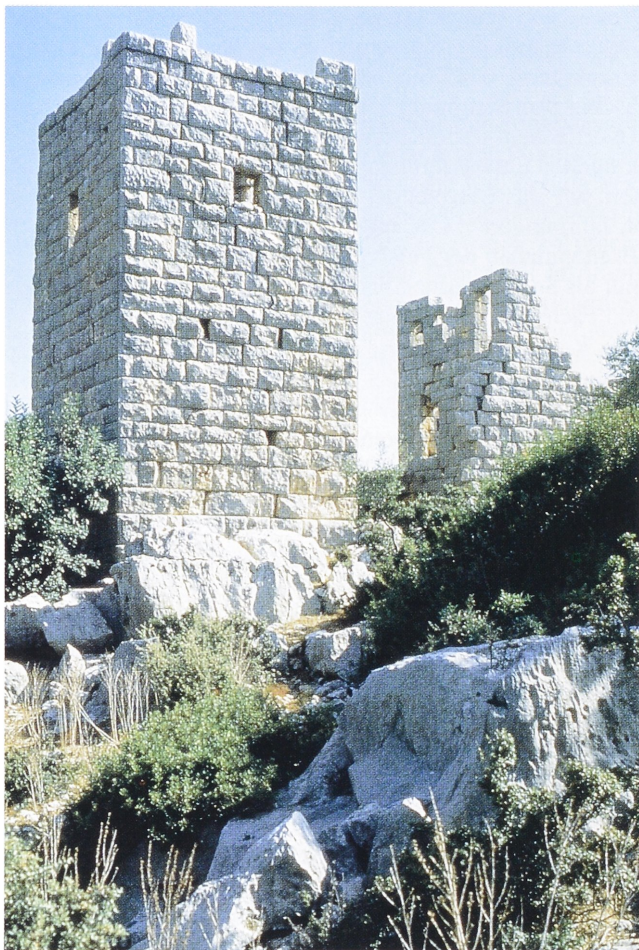
Abb. 7. Beymelek Dağ bei Demre, Süd-Türkei. Bossiertes Quaderwerk des Bergkastells direkt auf den Kalkfels gebettet, 4. Jh. v. Chr. (Foto: Verf.).
