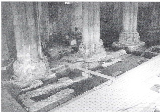
Abb. 20. Koblenz, St. Kastor. Pfeilerfundamente der Mittelschiffarkaden, ca. 2 m tiefe Punktfundamente im Hochflutlehm, Baubeginn 1198 (Foto: Verf.).
