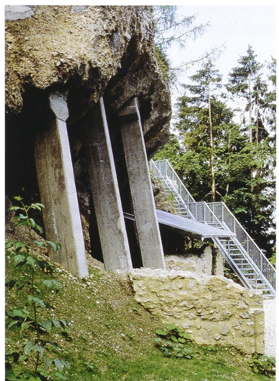
Abb. 13. Burgruine Schalun/Wildschloß. Ansicht von Nordosten vor der Sicherung 1992 (Foto: Verf.). Abb. 14. Burgruine Schalun/Wildschloß. Die neue Felsstützung von 1992 (Foto: H.-J. Frommelt).
