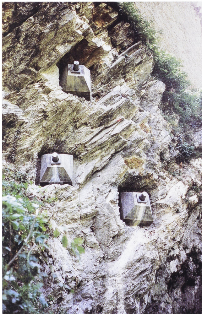
Abb. 8. Castello Mesocco. Rückverankerung der Felszone B. Steil darüber die Nordwand (Foto: Högl).
