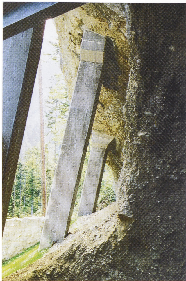
Abb. 13. Wildschloß Schalun. Variante 8: Schräggestellte Stahlbetonstützen zur Sicherung des Felsüberhanges (Foto: Landesverwaltung des Fürstentums Liechtenstein, Abt. Archäologie, H.-J. Frommelt).
