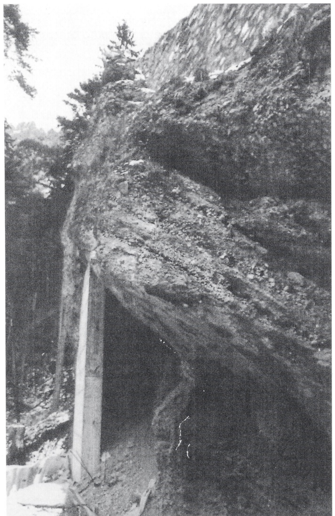
Abb. 11. Wildschloß Schalun. Felsüberhang im Bereich von Schnitt Q mit alter Felssicherung in Form einer vertikalen Stützwand (Foto: Landesverwaltung des Fürstentums Liechtenstein, Abt. Archäologie, H.-J. Frommelt).
