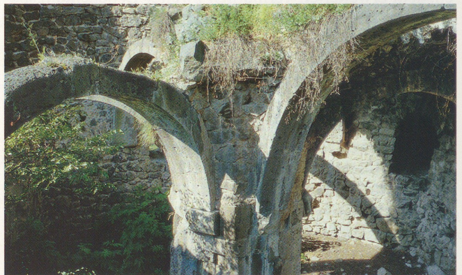
Abb. 7. Toranlage, Gewölbekonstruktion des Erdgeschosses (Foto: Verf., 1998).
