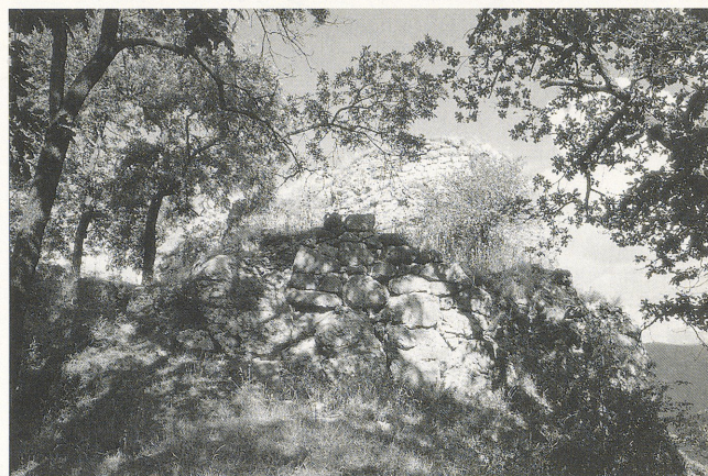
Abb. 3. Achtala, vermutlich ehemals „rückwärtiger Kontrollposten“ der Hauptburg (Foto: Verf., 1998).
