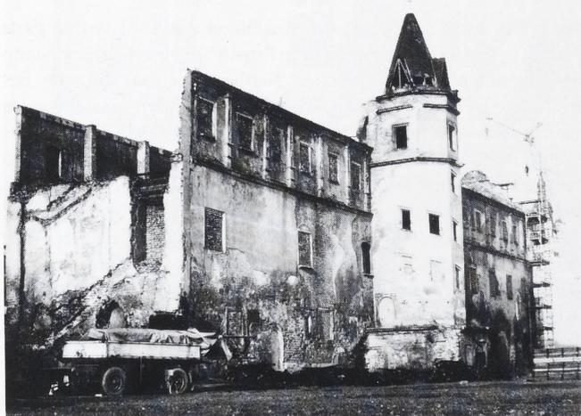
Abb. 1. Der Johannbau, Hofansicht von Südosten. Zustand November 1990 nach Abnahme des verrotteten Dachstuhls, der noch vor zehn Jahren eingedeckt gewesen ist. Die Sicherung des Restbestandes läuft nun endlich an (Foto: Jutta Bothe).
