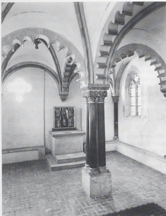
Abb. 4. Neuenburg bei Freyburg/Unstrut, obere Doppelkapelle (Foto: Beyer).
