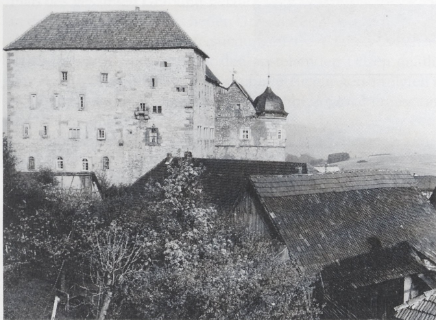
Abb. 5. Burg Kühndorf. Ansicht von Norden mit Kemenate.
