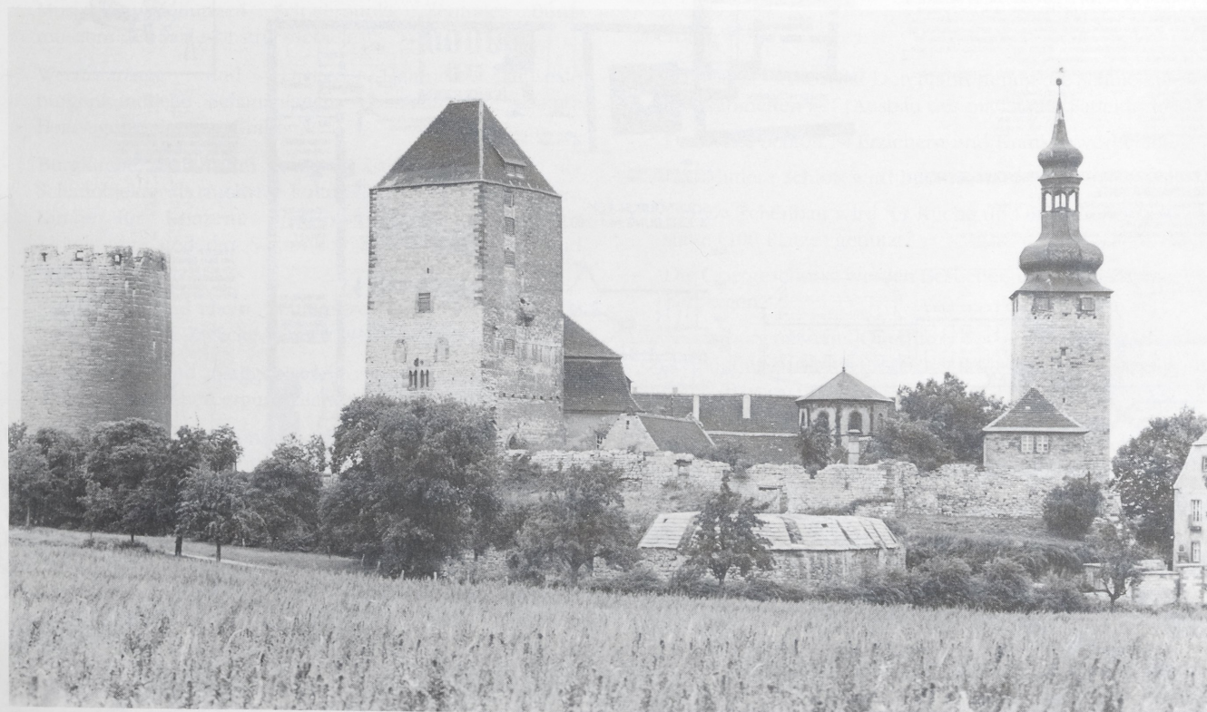
Abb. 9. Burg Querfurt. Südansicht mit (v.l. nach r.) den Bergfrieden „Dicker Heinrich“, Marterturm und Pariser Turm.
