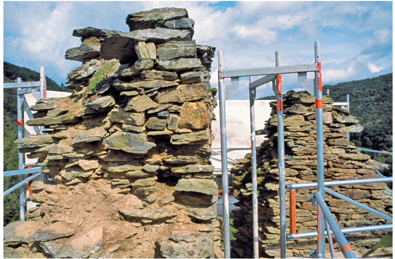
Abb. 14. Westmauer, Abbruchkante mit Resten der Fensterlaibung (Foto: Verf., GDKE, 2001).
