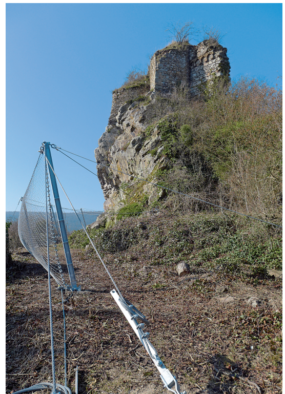
Abb. 5. (rechts) Steinkallenfels, die obere der drei Burgen (Burg Stein). Teilansicht von Nordosten mit neu errichtetem dynamisch wirkendem Fangzaun (Foto: Verf., 2014).
