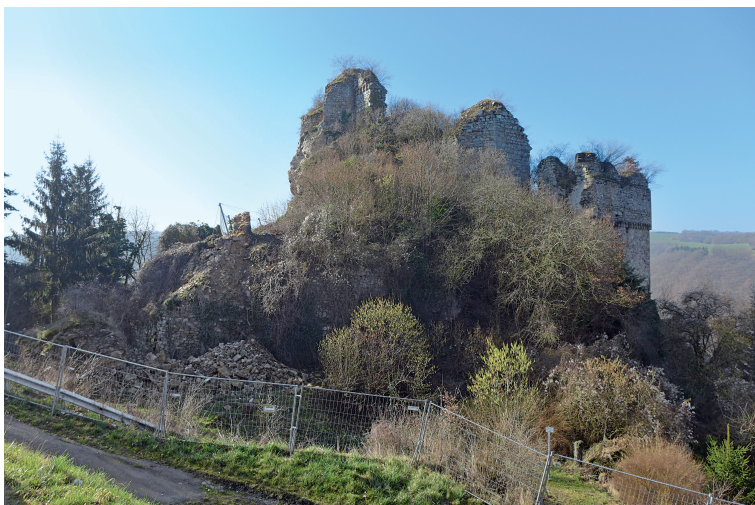
Abb. 4. (unten) Steinkallenfels, die obere der drei Burgen (Burg Stein) von Norden. Halblinks in den Halsgraben abgekippter Torturmrest, auf halber Höhe darüber der neue Fangzaun. Im Vordergrund die weiträumige hangseitige Absperrung (Foto: Verf., 2014).
