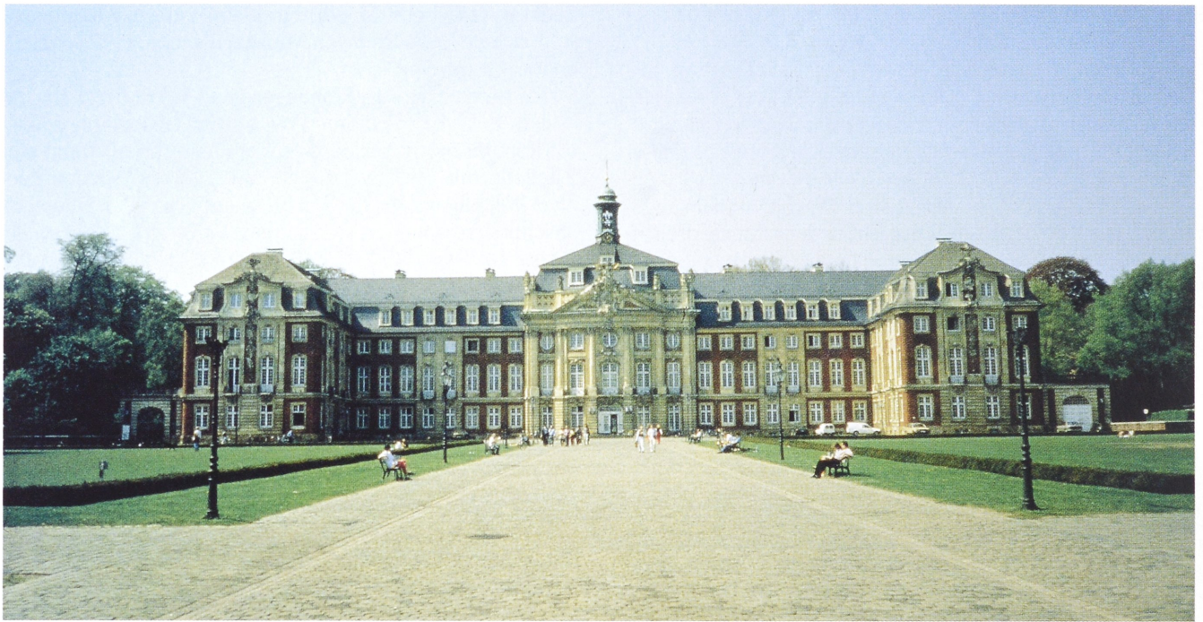
Abb. 17. Münster, Residenzschloß. Stadtseite. Ansicht von Osten (Foto: Verf.).
