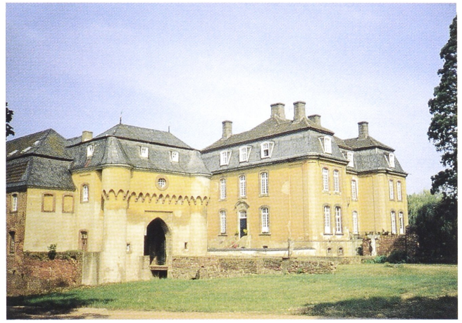
Abb. 8. Kleinbüllesheim, Große Burg. Ansicht des Torhauses der Vorburg und der Hauptburg von Südosten (Foto: Verf.).
