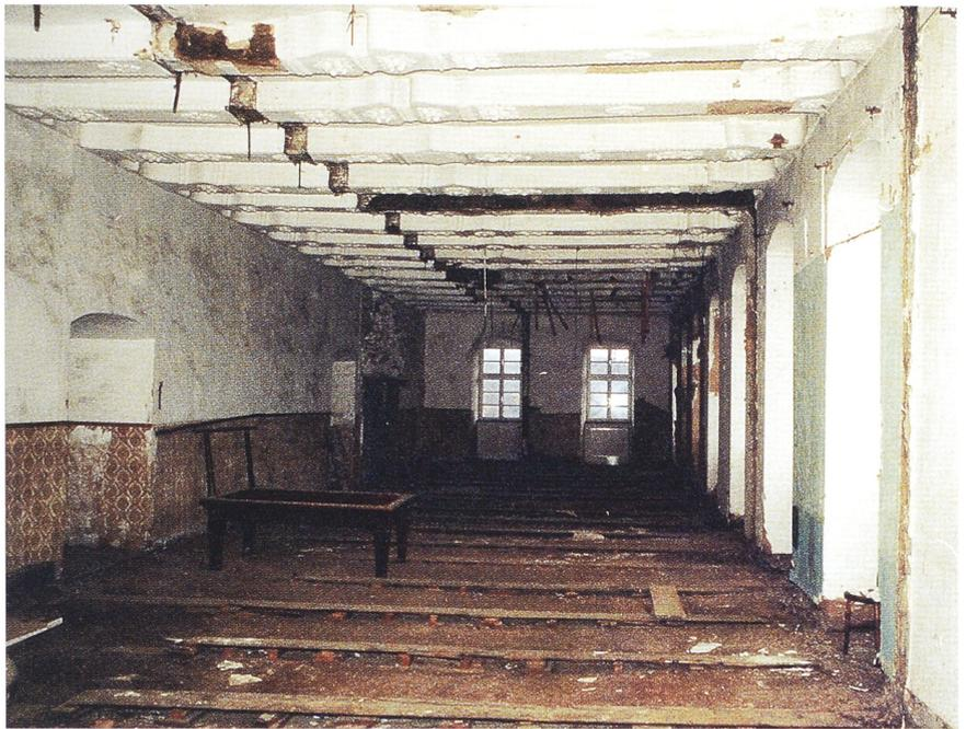
Abb. 7. Saal im Obergeschoß nach Beseitigung der Zwischenwände und des Fußbodens (Foto: Verf.).
