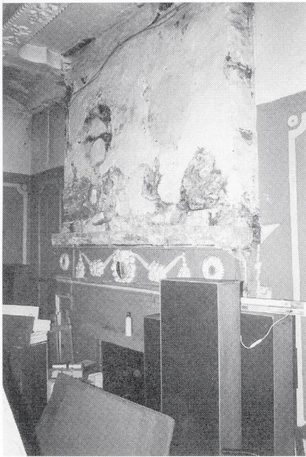
Abb. 6. Kamin im Erdgeschoß. Bis auf Reste abgeschlagener Stuckaufsatz (Foto: Verf.).
