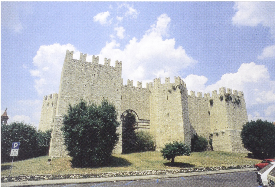
Abb. 4. Südostseite mit Nebenportal (Foto: Verf. 1995).
