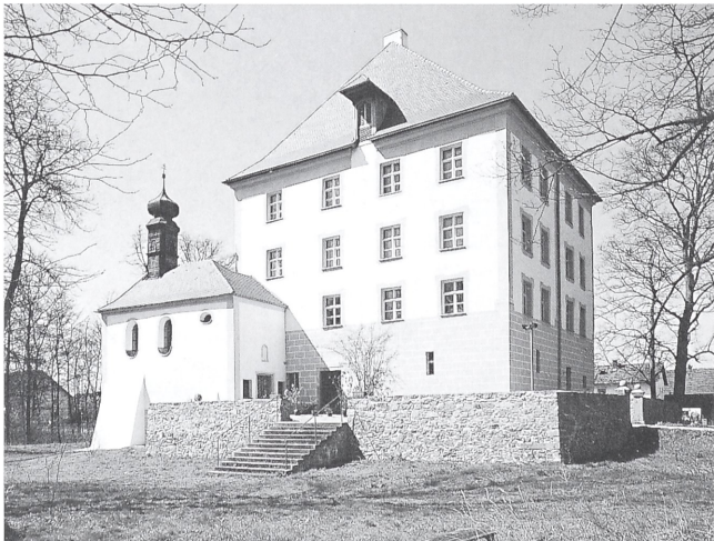
Abb. 3. und 4. Schloß Loham vor und nach der Instandsetzung (Fotos: Hypo-Kulturstiftung, vor 1980 und 1997).
