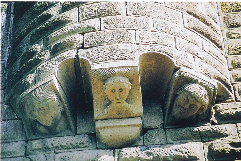
Abb. 3. Burg Trifels. Hauptturm, Detail Kapellenerker. Maskenkonsolen: links und rechts staufisch, Mitte Ersatz des 19. Jahrhunderts (Foto: Reither).
