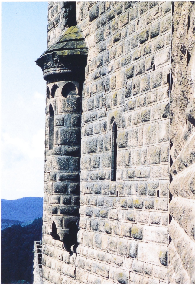
Abb. 2. Burg Trifels. Hauptturm, Ostseite, Kapellenerker (Foto: Reither).
