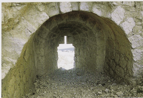
Abb. 6. La Mota, Burg, Turm, Schießkammer nach Osten (Foto: Verf., 1999).
