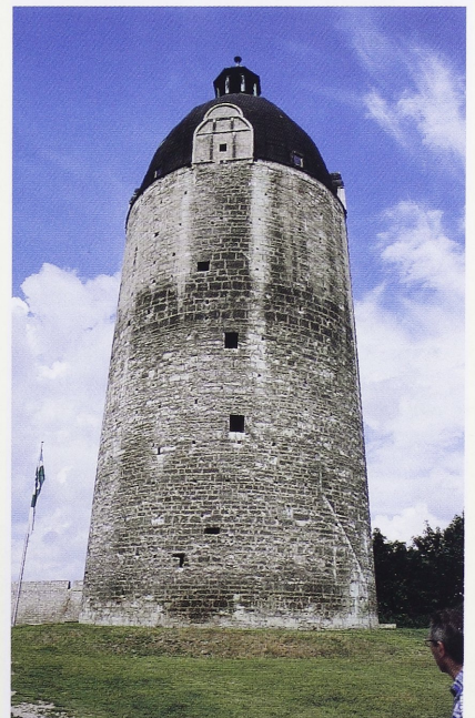
Abb. 10. Neuenburg, Rundturm 3 (Foto: Verf., 1999).
