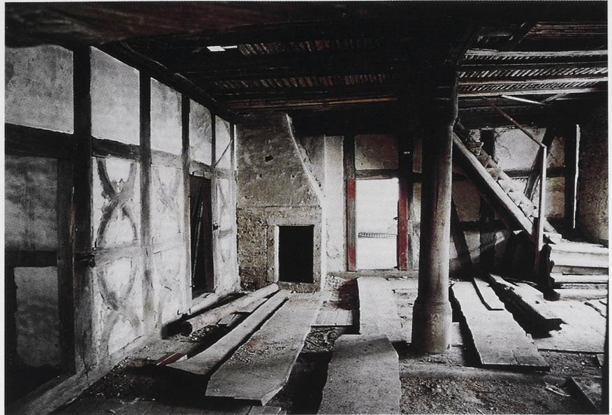
Abb. 3. Mitteldiele im Obergeschoss mit Rundholzstütze, Kamin und Fachwerk-trennwand (Foto: O. Schramm, Schweinfurt).
